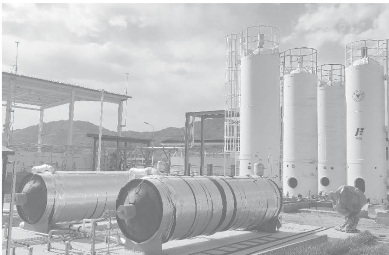
张家口望山制氢加氢站 45Mpa 高压氢气存储设施
