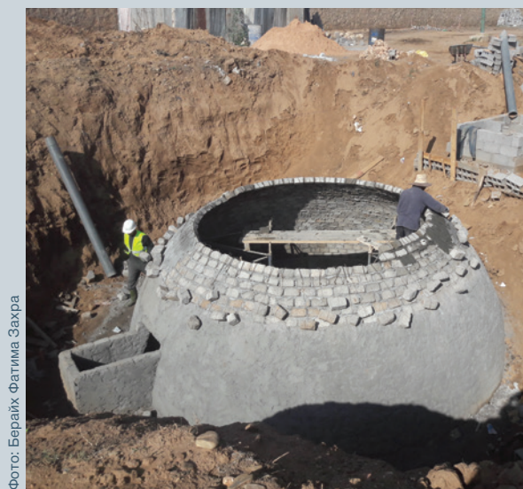
Строительство компостной машины BIODOME в Марокко
